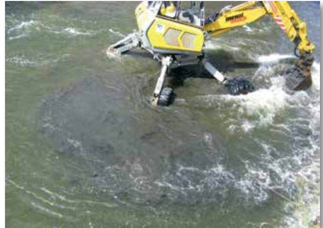
Mit dem Schreitbagger im unteren Schleusen graben
